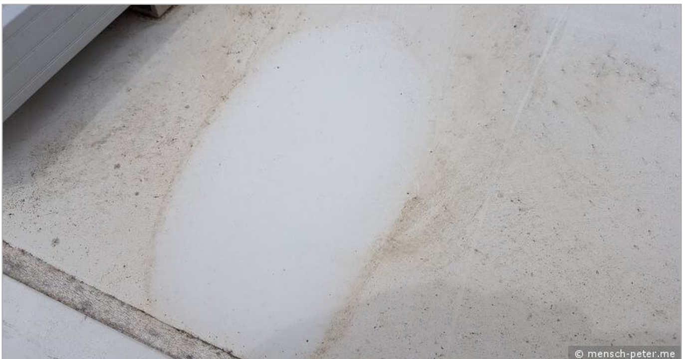
Anwendungsbeispiel am Dach (Bild 1/1)
