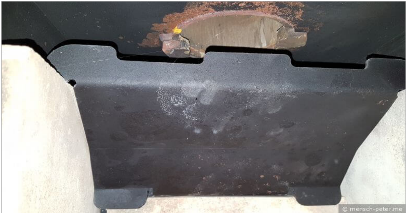
Holzofen Willow - Abluftblech (Bild 1/1)
