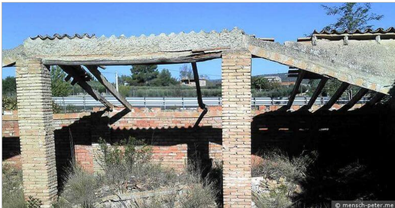
Ausblick vom Eingang auf die Autobahn (Bild 2/4)
