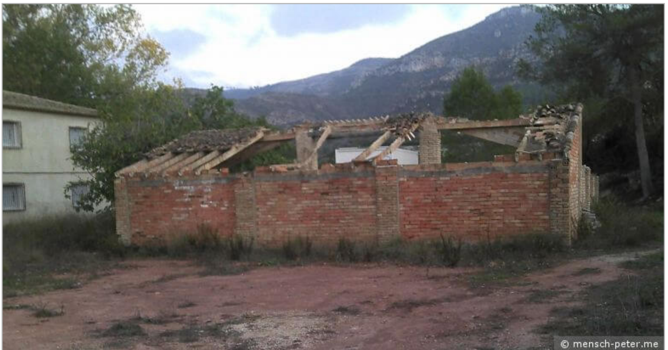
Stellplatz in der Nähe von Terrateig (Bild 1/4)
