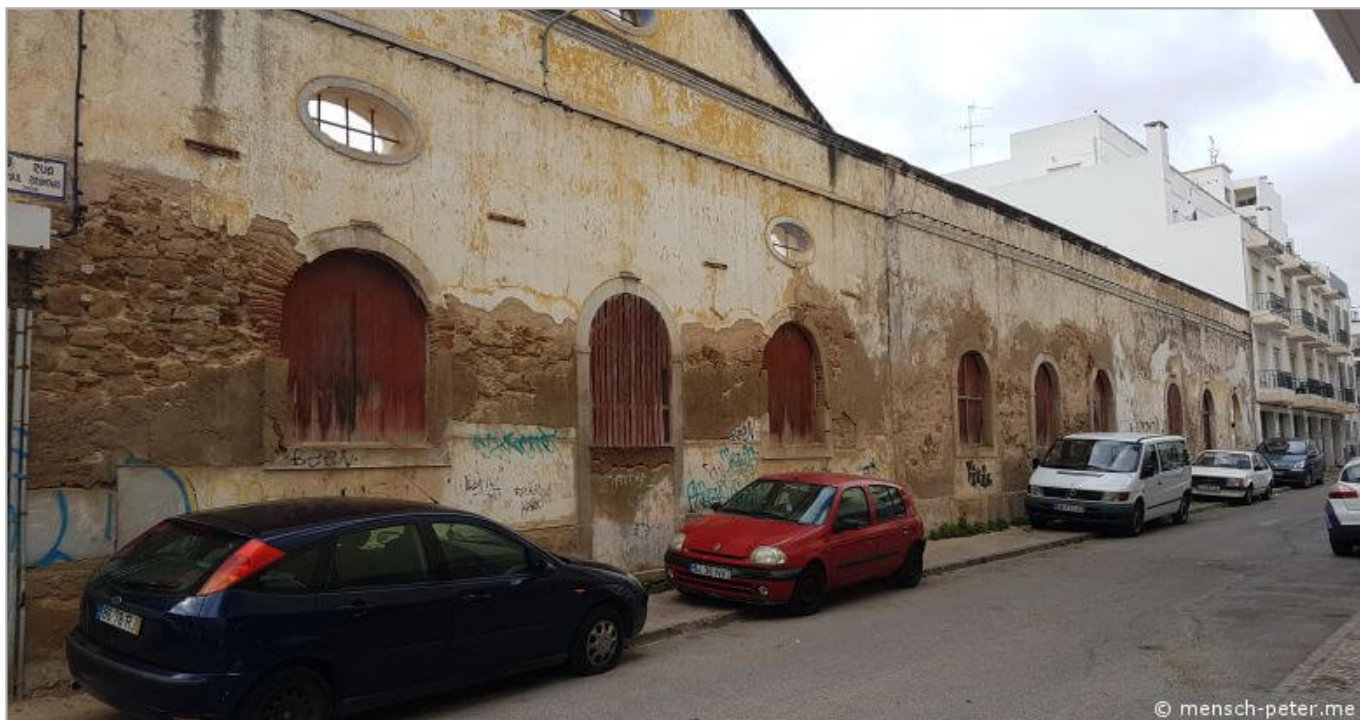
Ruine von außen (Bild 1/5)
